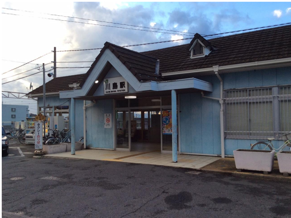
【川島駅 工事着手前（平成 26 年 10 月）の写真】
