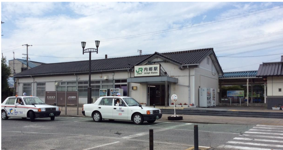
【内郷駅 工事着手前（平成 26 年 10 月頃）の写真】
