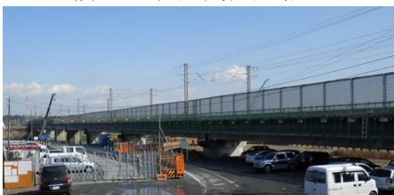
橋りょう区間防風柵
