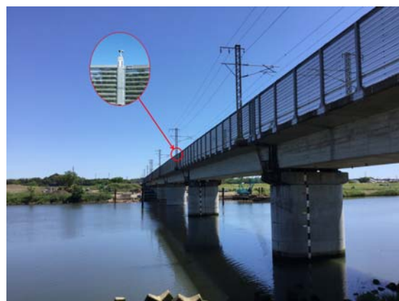
水戸～勝田間 那珂川橋りょう
