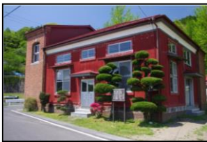
【旧町屋変電所】
