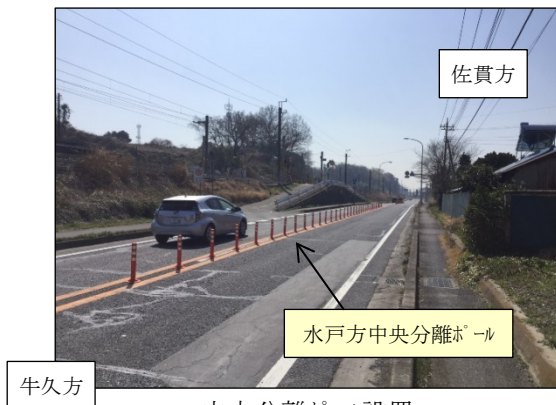
中央分離ポール設置
