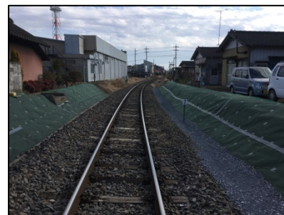
防草シート敷設後
