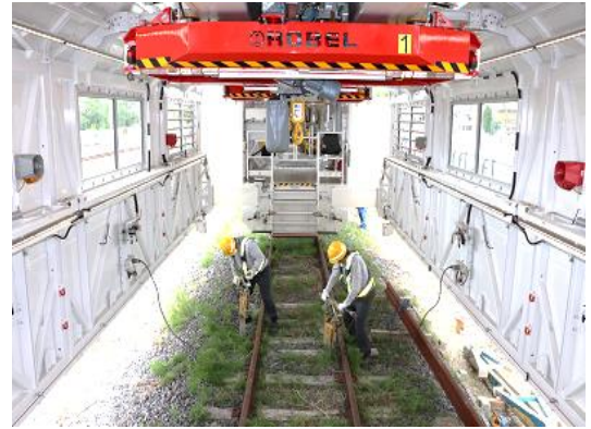
写真2 車両内での作業状況
