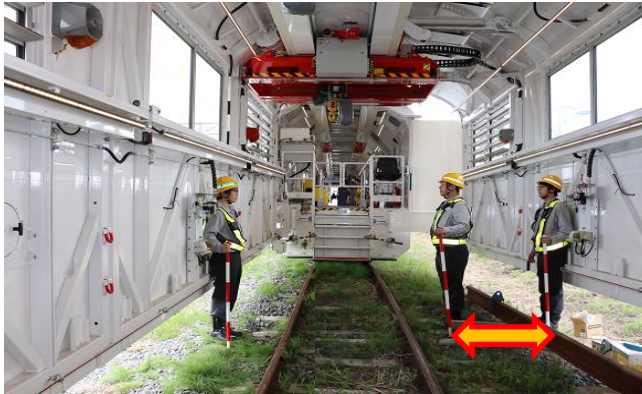
写真1 拡幅状況 (2,430 mm→4,430 mm (両側拡幅時))
