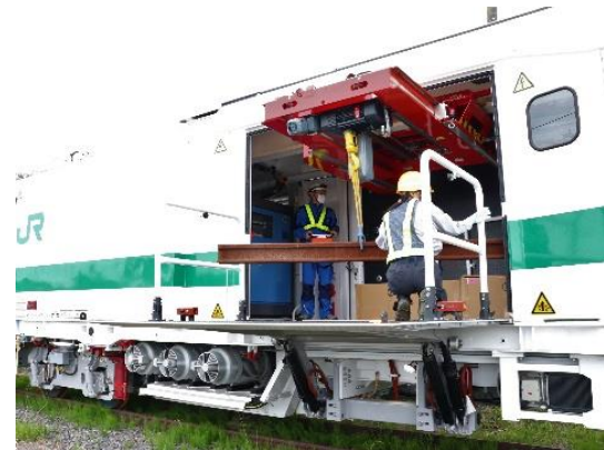
写真6 パワーリフターとクレーン作業
